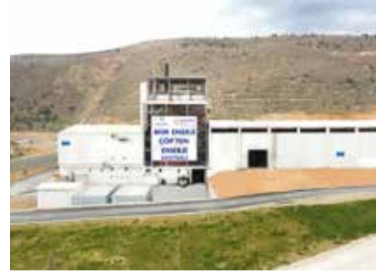
Malatya Belediyesi Çöpten Enerji Santrali
