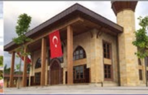
650 m 2 Hava Kaynaklı 64 kW Karaosmanoğlu Camii - Yuvacık/ Kocaeli
