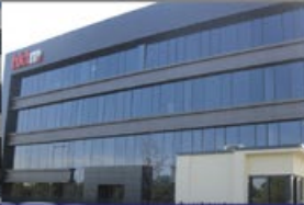
4000 m 2 Toprak Kaynaklı 60 kW ve Hava Kaynaklı 140 kW Fabrika-Gebze
