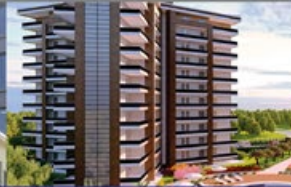
8100 m 2 Hava Kaynaklı 528 kW Yelkenevler2 /66 daire-Güzelyurt/Manisa
